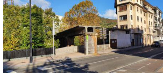
Restos del puente del antiguo ferrocarril sobre el Ibaieder
