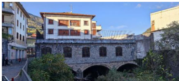
Edificio de viviendas. Cubrición del Ibaieder. Estrada San Martin
